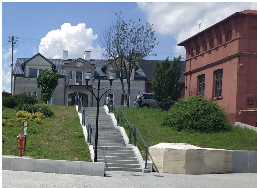
Bunkier - po zakończeniu prac rewitalizacyjnych, zabezpieczony i wyeksponowany na Placu Straży
